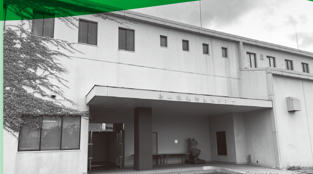
平成16年3月 管理棟耐震補強工事後
