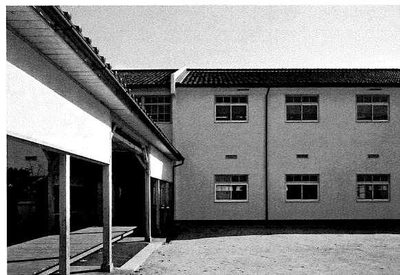
上履き移動が可能となった中央渡り廊下
