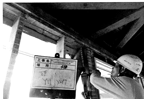
横架材継手 HD ジョイント 25kN
