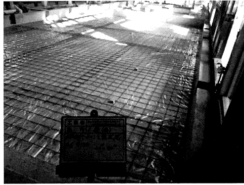
土間防湿工事
