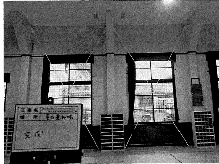
壁ブレース補強
