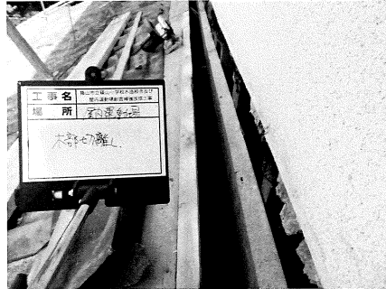
木造部切り離し工事
