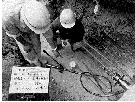
壁ブレース補強
