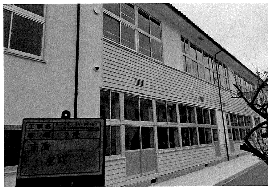
外壁南面完成（2号棟）
