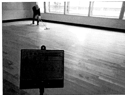
床フローリングオイル拭き
