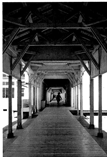
中央渡り廊下完成
