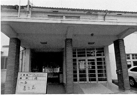
玄関着工前（1号棟）
