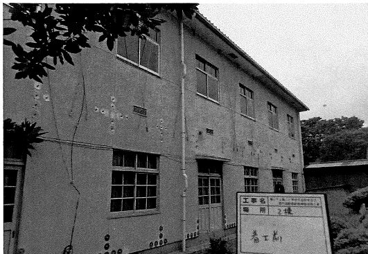
外壁北面着工前（2号棟）
