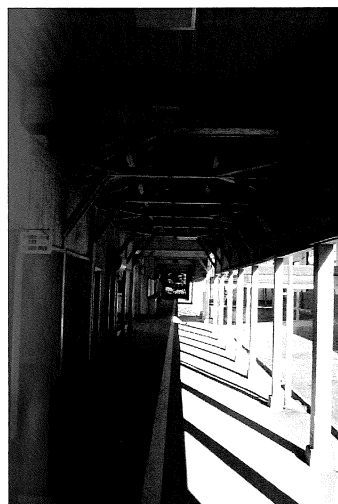
中央渡り廊下着工前
