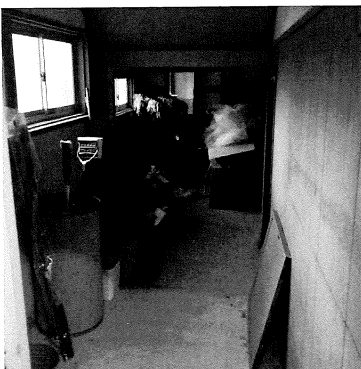
幼児用便所着工前（1号棟・東階段下）
