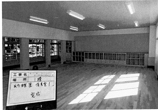
幼稚園保育室完成（1号棟）
