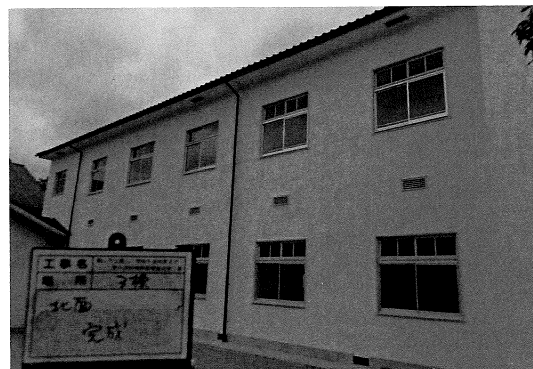
外壁北面完成（3号棟）
