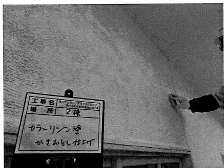
外壁白モルタル掻き落とし
