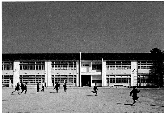
外壁南面完成（5号棟）
