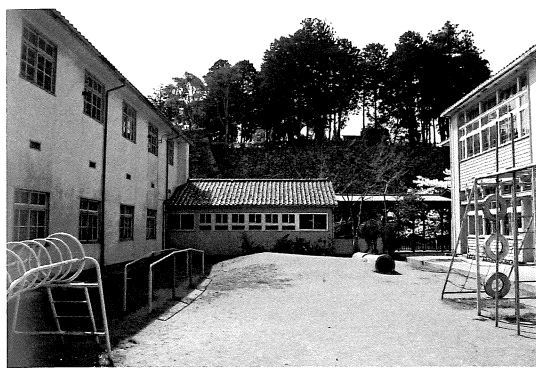
連絡通路・E V棟着工前（4-5号棟間）
