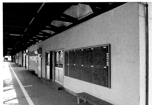
西側渡り廊下着工前（4号棟）
