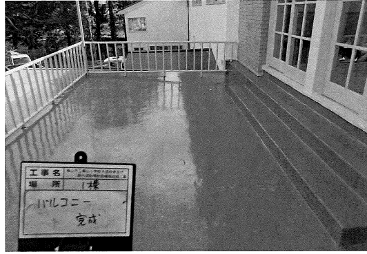
バルコニー完成（1号棟）
