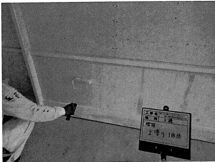
腰板塗装工事
