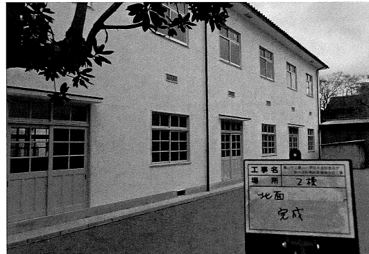
外壁北面完成（2号棟）
