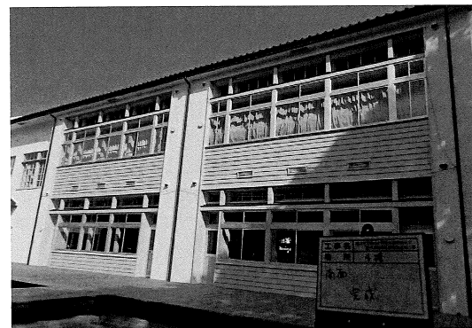
外壁南面完成（4号棟）
