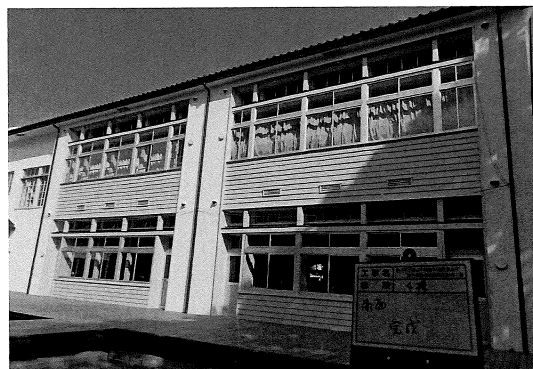
外壁南面着工前（4号棟）
