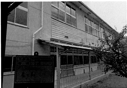
外壁南面着工前（2号棟）
