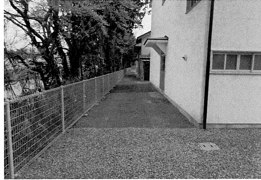
東通路完成（1号棟脇）
