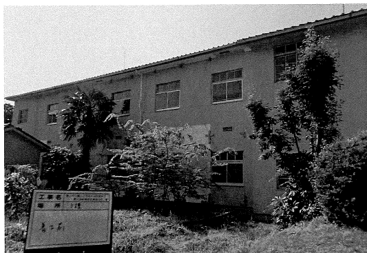
外壁北面着工前（3号棟）
