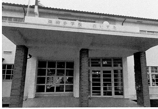
玄関完成（1号棟）
