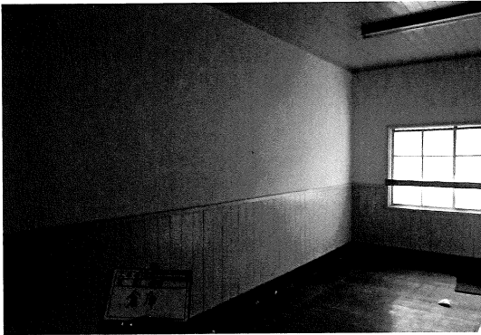
2階便所着工前（4号棟・旧倉庫）
