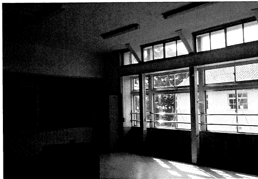
図書室着工前（4号棟・旧教室）
