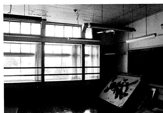
普通教室着工前（5号棟・旧多目的室）
