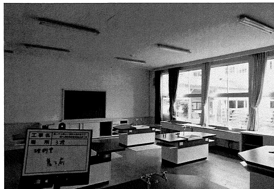
理科室着工前 (3号棟)
