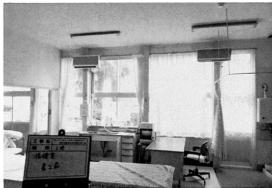
家庭科室着工前 (3号棟・旧保健室)
