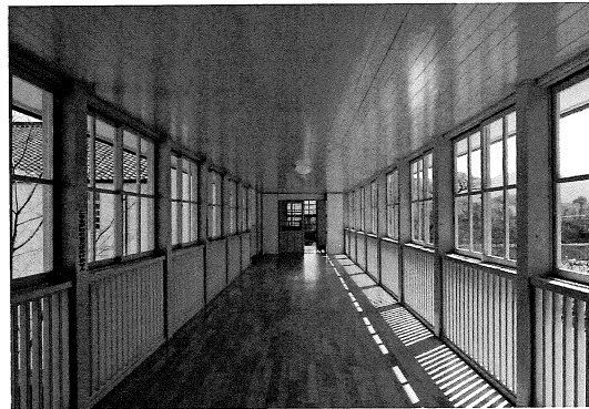
連絡通路完成（4-5号棟間）
