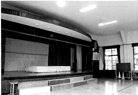
屋内運動場着工前
