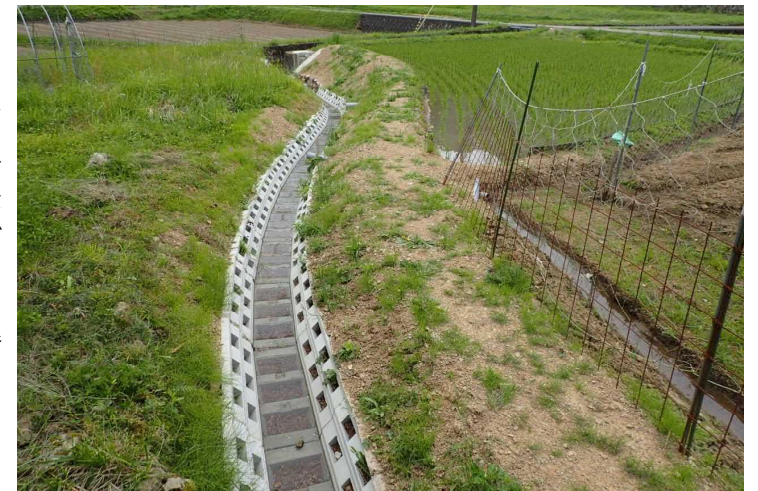
▲「トンボトラフ（ヨシキモデル）」。落ち込んだカエルが這い出せ、魚たちも暮らせる生きものに優しい水路です
