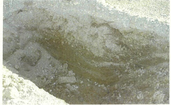
固形化した砂利 ↓ 旧中学校部分 ↓ 地山
