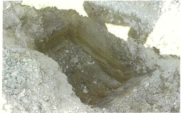
固形化した砂利 ↓ 旧中学校部分 ↓ 地山
