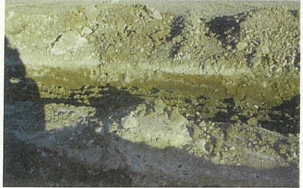
固形化した砂利 ↓ 旧中学校部分(基礎の残りあり) ↓ 地山
