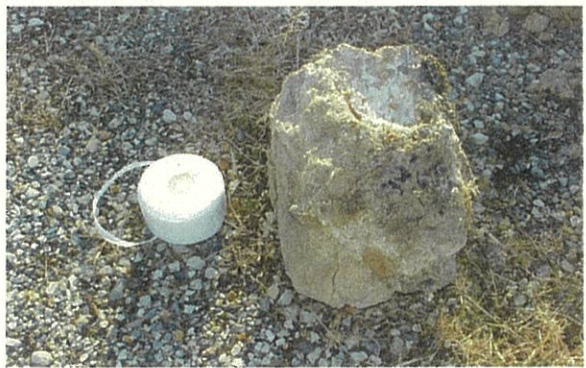
コンクリート片
