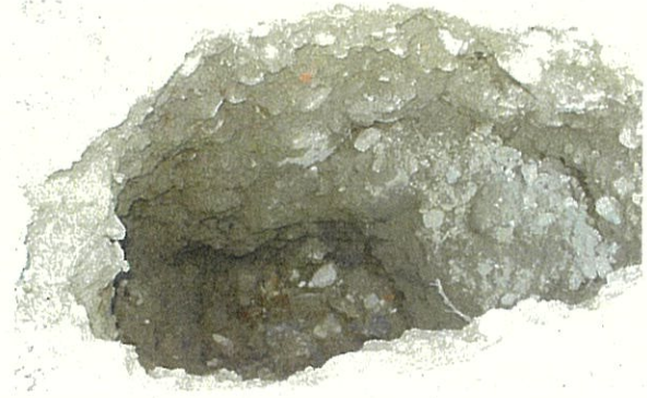
固形化した砂利 ↓ 旧中学校部分 ↓ 地山
