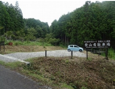
写真 6-11 野々垣地区の駐車場
