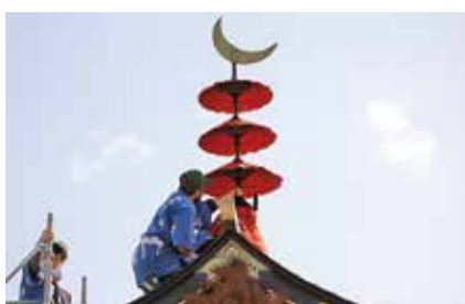
屋根の上に高々と取り付けられる「鉾」
