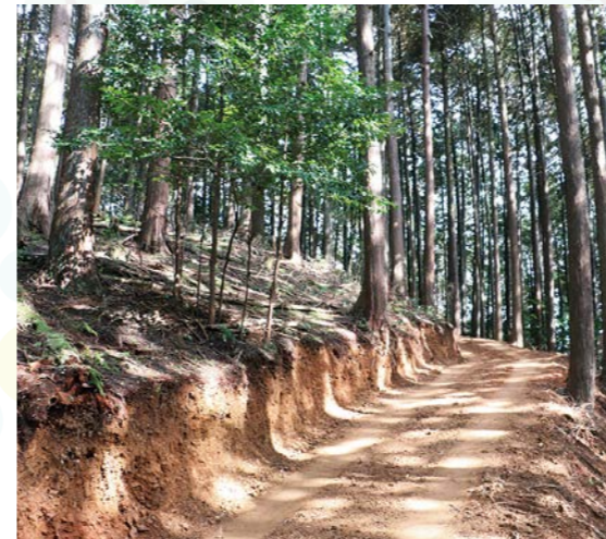
幅2～2.5m程度の作業道
