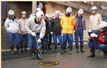
消火栓の点検
