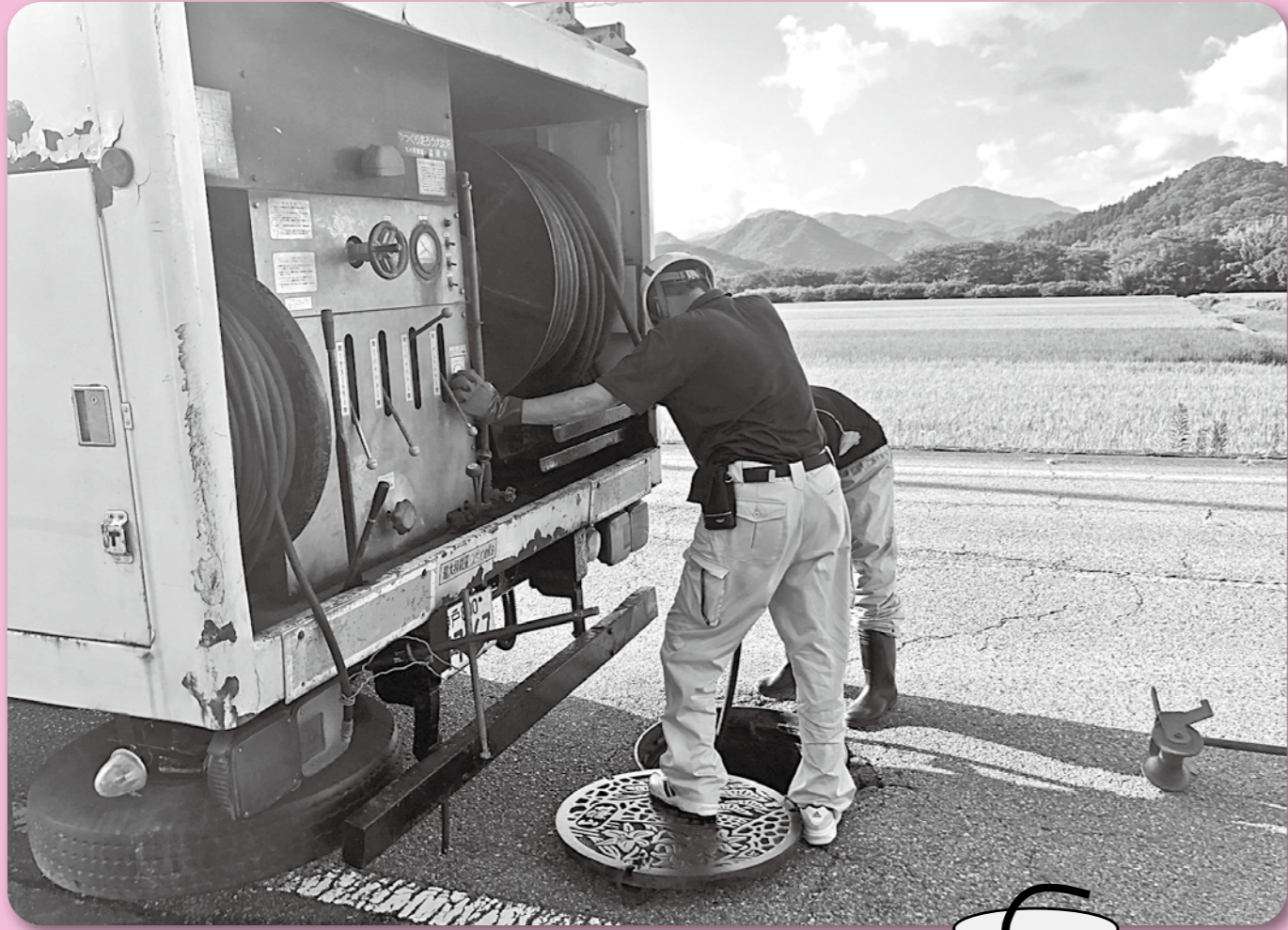
写真：下水道管の閉塞が発生した際の作業風景
