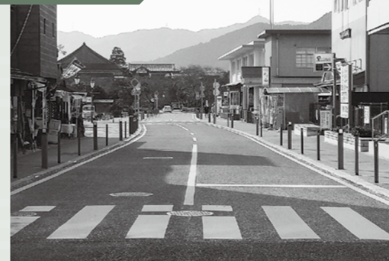
▼令和2年に無電柱化が完了し、広い視界に大書院の雄大な屋根が迫ります
