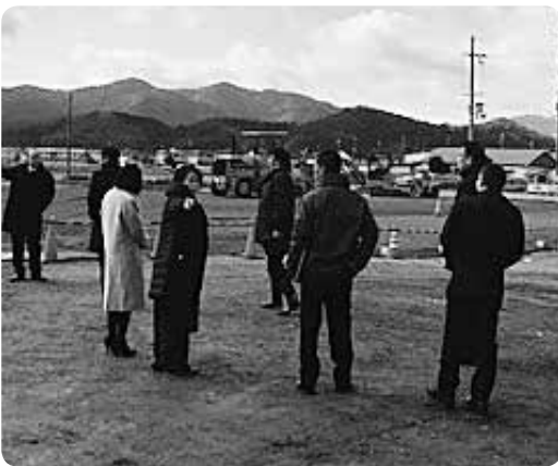
造成中の西町駐車場
