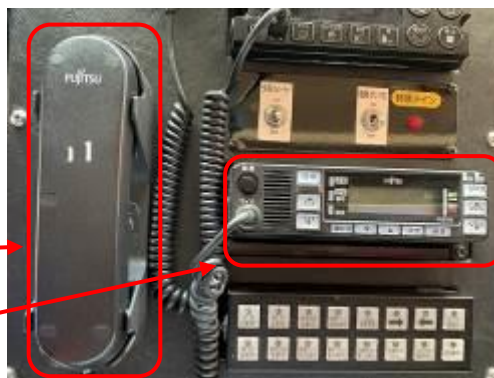
車載型無線機の写真（化学消防車：ささしょう 11）
