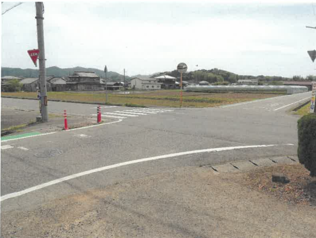
事故現場となった郡家と乾新町境界の見通しの良い四つ辻
