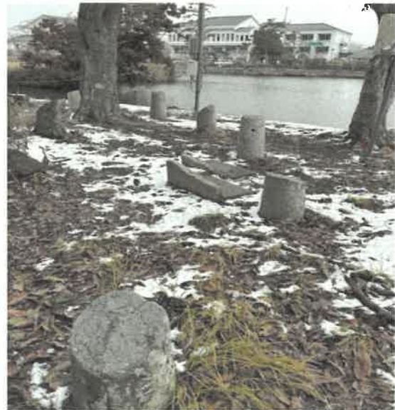
石柱が壊れ、散乱状態
