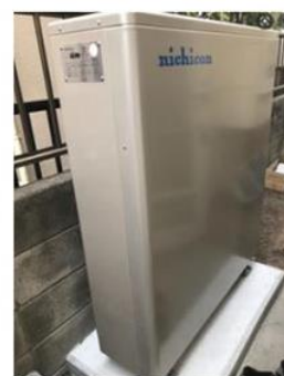
リチウムイオン蓄電池 (16.6kWh)
