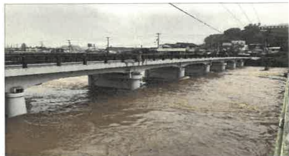
平成30年7月豪雨の篠山川・京口橋
