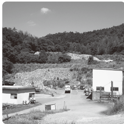
最終処分場の埋立状況
