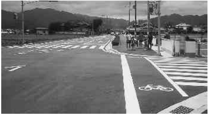
市道西紀丹南線改良工事
