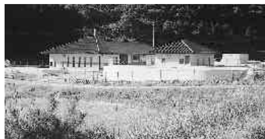
小野原処理区処理場
