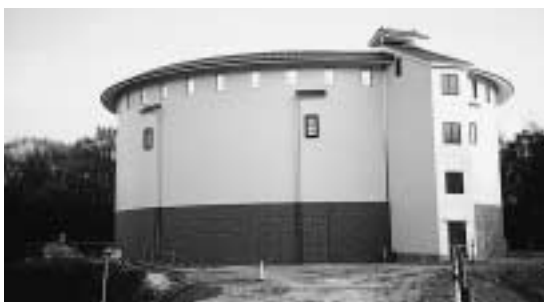
県水受水の前山配水池
