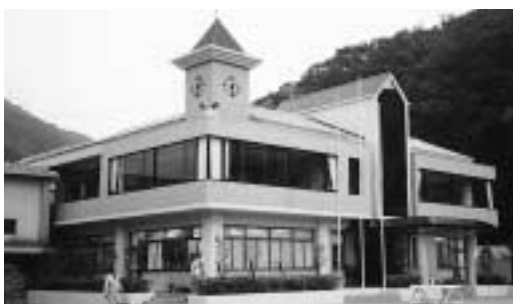
12年3月竣工 大芋小学校
