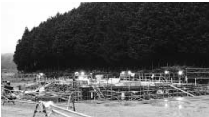
完成が待たれる大草処理場
