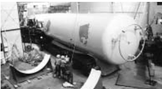
天然ガス変換に伴う工事
