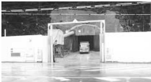
にしきトンネル
