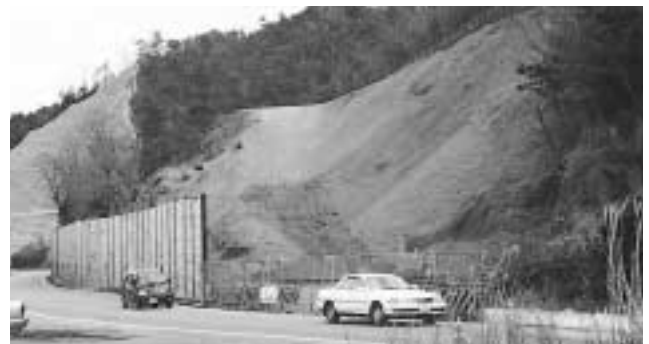
国道372号の改修 栗栖野付近
