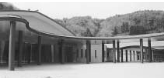
完成した篠山市営斎場
