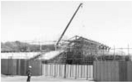
建設中の篠山市民センター（仮称）
