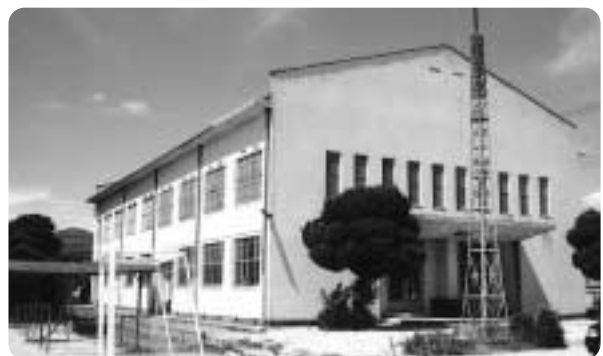
昭和29年に建築された八上小学校講堂
