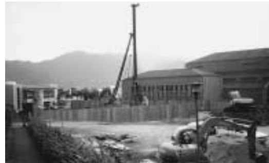
四季の森会館東側に建設中
