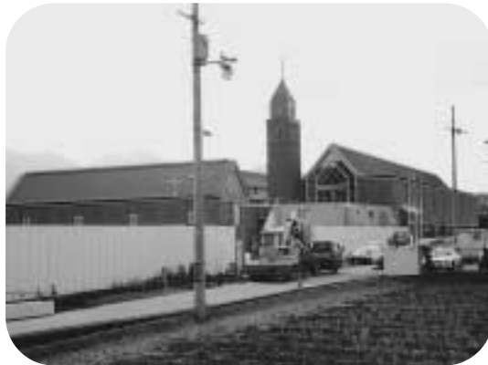
平成15年4月オープン予定の中央図書館
