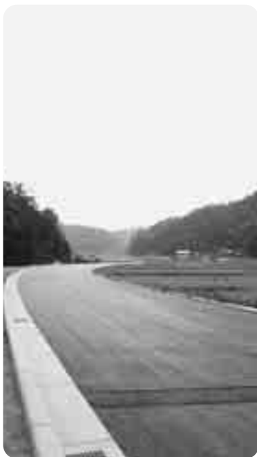
国道372号線 日置バイパス
