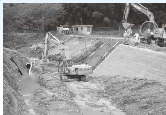
河川災害復旧工事（宮田川）
