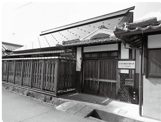
準備が進むお試し住宅(東新町)
