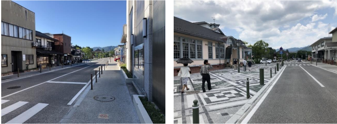
市道大手線無電柱化事業 整備後の状況
