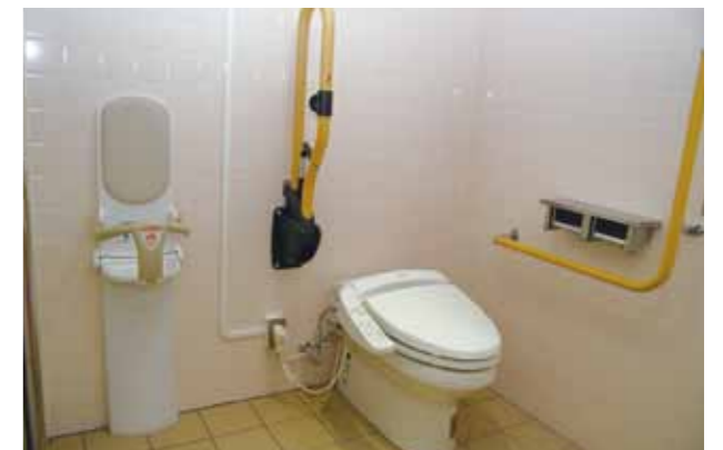
障害者用トイレ改修
