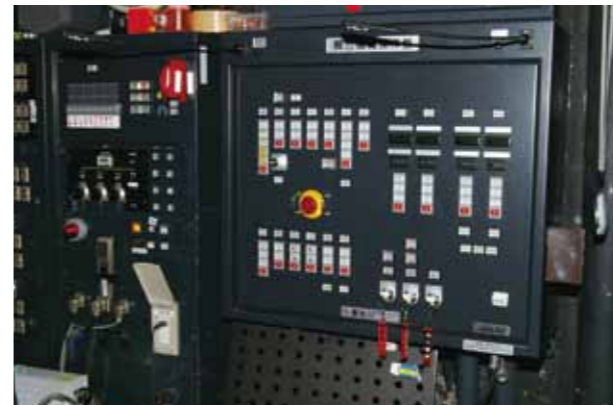
舞台吊物機構改修
