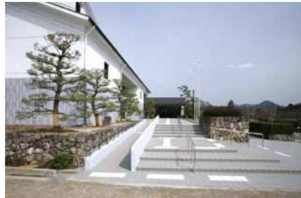
アプローチスロープ増設(玄関)
