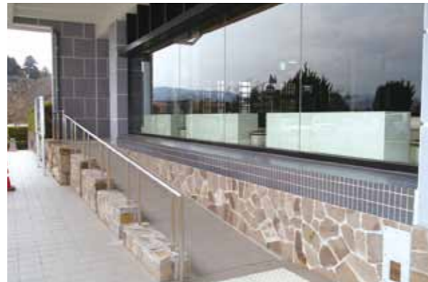
アプローチスロープ増設(事務所横)
