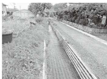
曾地口地区に整備された木製水路
