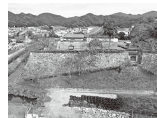
修理を進めている二の丸南西の高石垣(篠山城跡)
