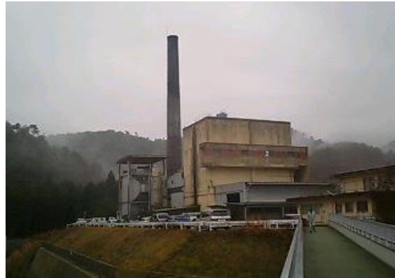
解体予定の旧焼却炉全景
