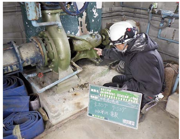
揚水ポンプの機能診断
