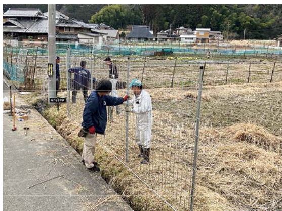
集落での獣害柵の設置
