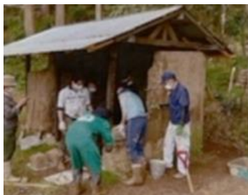
農業遺産の維持と活用、 灰屋の修繕、焼土肥料の分析
