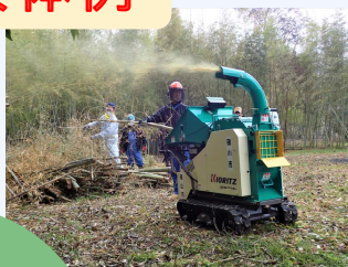
竹粉碎機による竹林整備
