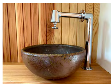
1階・2階のトイレには丹波焼を手洗器に使用した。
