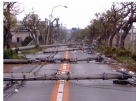
図 5.1 倒壊した電柱による道路閉塞 (出典：国土交通省HP)
