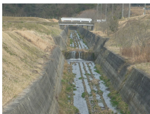
落差工により分断された河川
