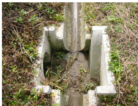
落下した生物が這い出せる製品
