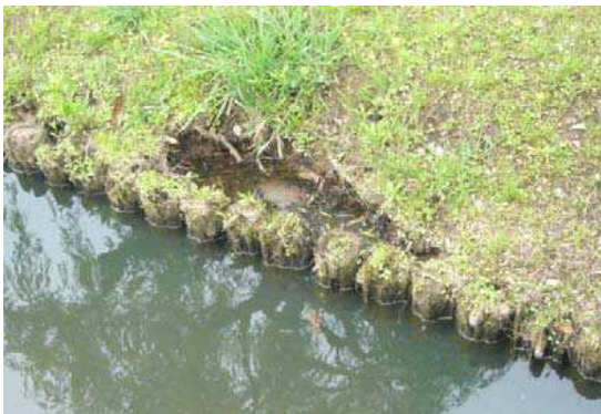
植生に覆われた片側木杭水路
