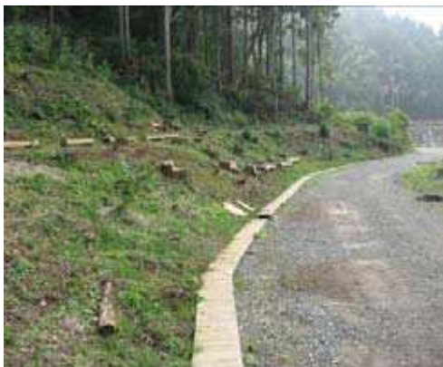
木製蓋板設置(生き物の落下を防ぐ)
