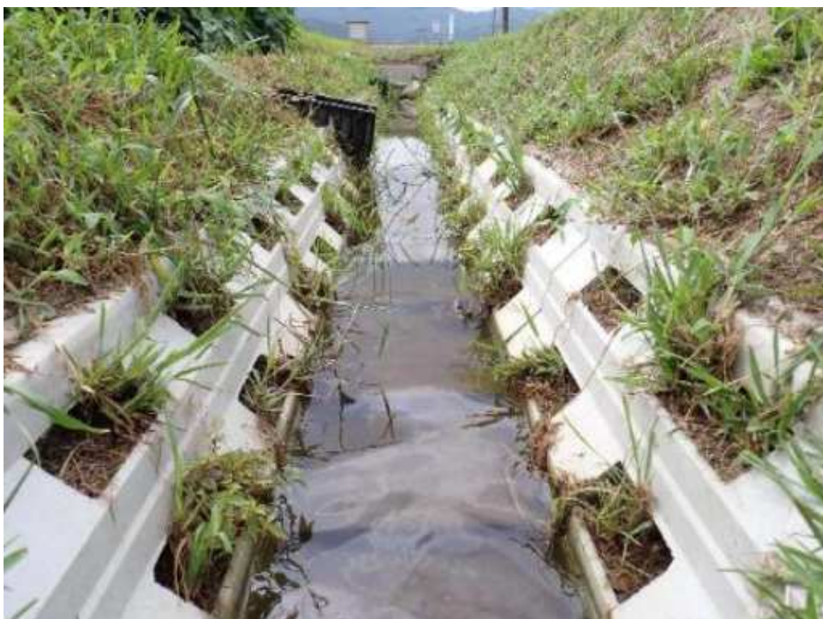
底面・壁面ともに穴あき（ヨシキモデル）
