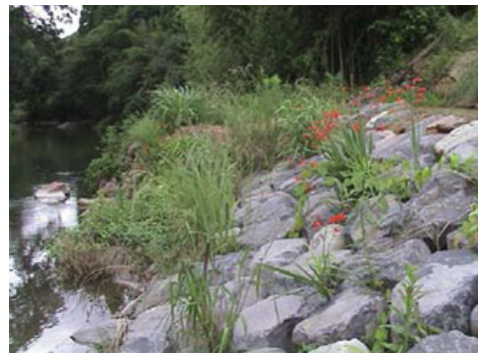
現地採取石を使用した護岸
