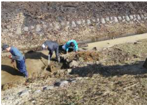
水路の土砂さらえ
