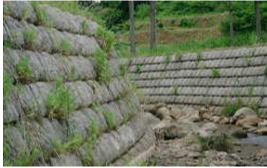
（天然石風ブロック積：隙間に植物が自生）
