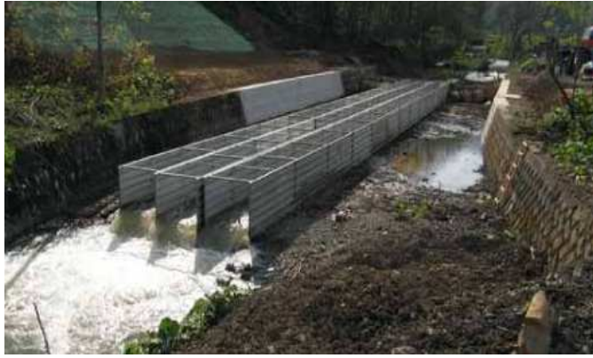
工事中の河川通水を確保
