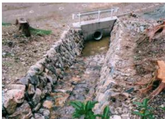
自然石水路：両側及び底
