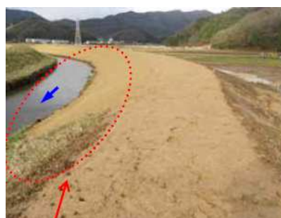
現地土埋め戻しによる農地との連続性確保
