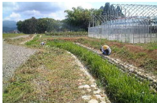
施工後1年で底部に植生が繁茂
