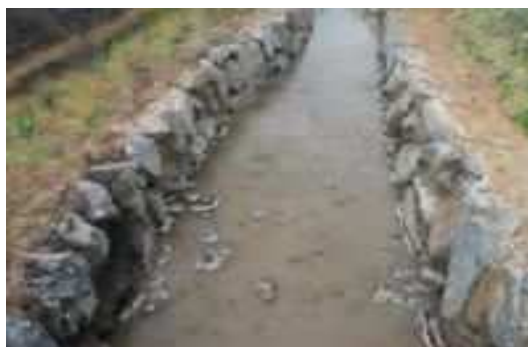
コンクリート製品に石材を貼付
