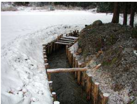
間伐材を使用した木製水路
