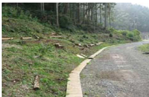
コンクリート製品に木製蓋を設置し 生物の落下を防ぐ
