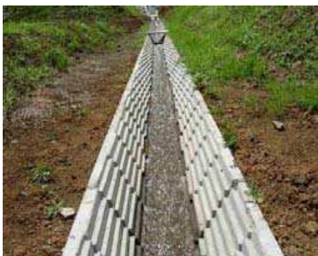
壁面を階段状スロープ
