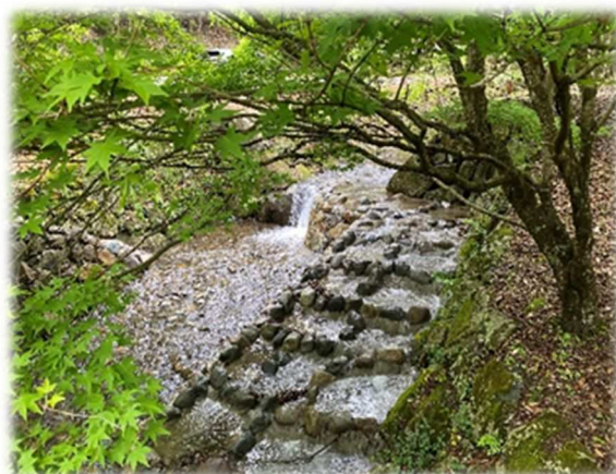
⑬ 原川魚道設置（後川新田笹坊）
