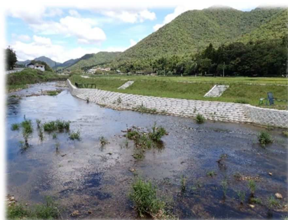
⑧ 四斗谷川親水護岸整備（今田町上立杭）
